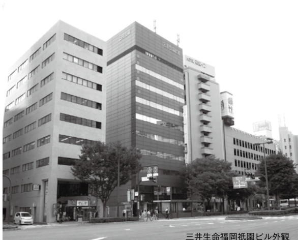
三井生命福岡祇園ビル外観
